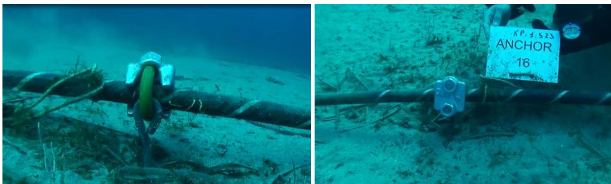
Figure 26 : Autre système de fixation du câble à l'ancre visant à limiter le risque de croche de l'ancre dans les filets de pêche (Orange Marine)
