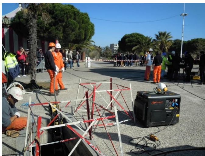
Figure 20 : Tirage du câble en dehors de la chambre plage avant raccordement
