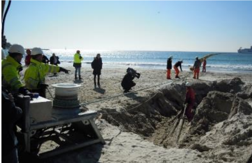
Figure 19: Opération de tirage du câble à terre avec un cabestan hydraulique (source : Orange marine)
