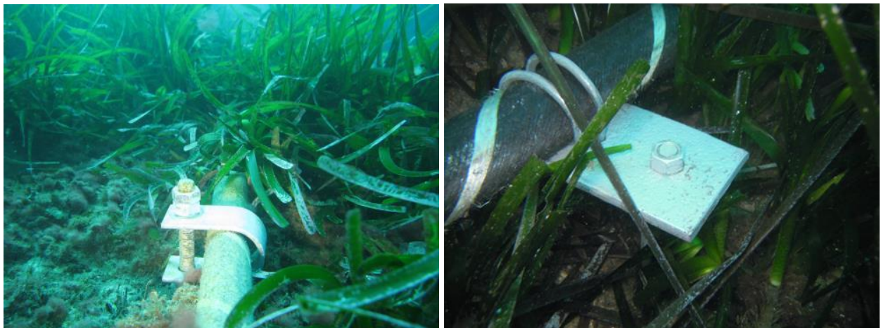
Figure 25 : Deux systèmes de fixation d'ancres à vis installées en zone d'herbier (photo : setec in vivo)
